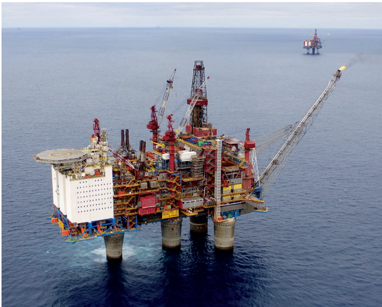
Gullfaks A. Foto: Øyvind Hagen/Statoil
