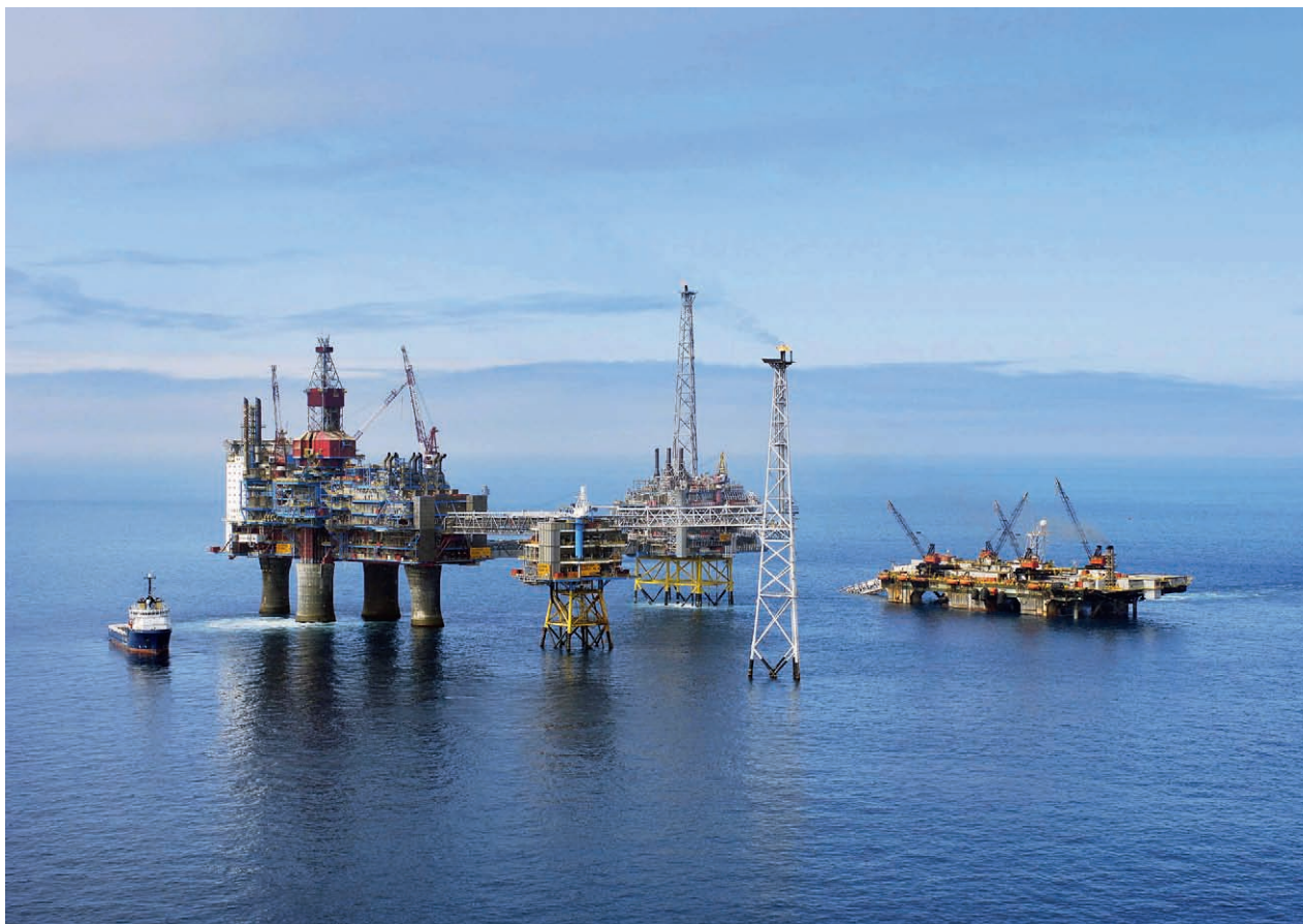
Fra venstre Sleipner A, R, T og flammetårn. Rørleggingsfartøyet Acergy Piper til høyre i bildet. Bilde tatt i 2005 i forbindelse med leggingen av rørledningen Langeled. Foto: Kim Laland/StatOil
