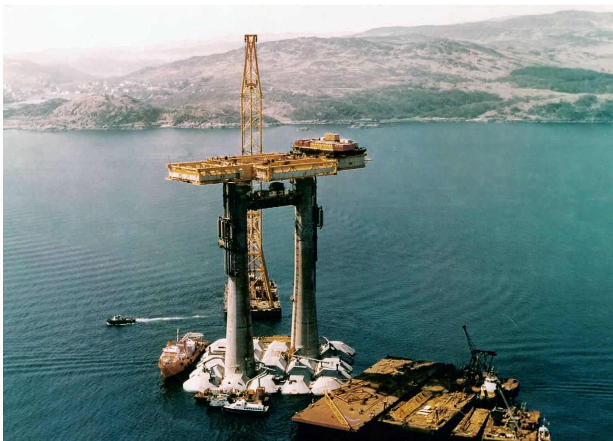
TP1 fotografert under bygging i Skottland. Foto fra brosjyren Frigg Field Treatment Platform TP1. Foto: Elf
