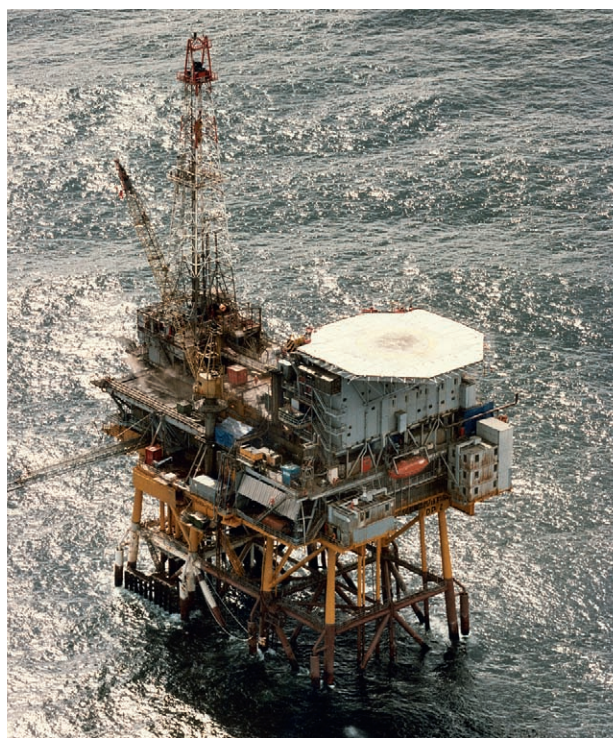
Boreplattformen DP2. Foto: Total
