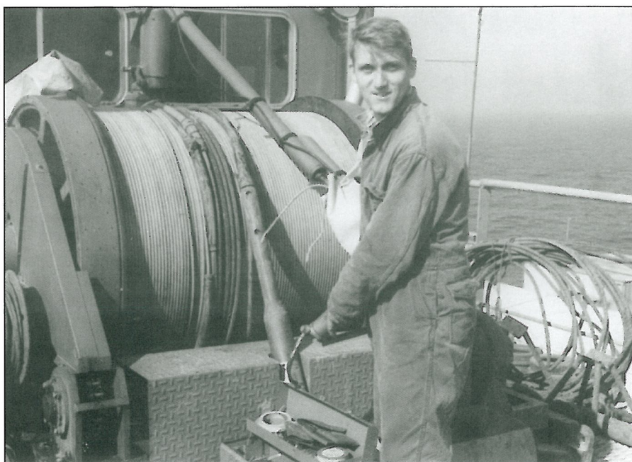
Svein Paulsen ved vinsjen på «logging uniten» på «Ocean Traveler» i 1966. Vinsjen ble brukt til å kjøre loggeutstyr opp og ned av borehullet.
