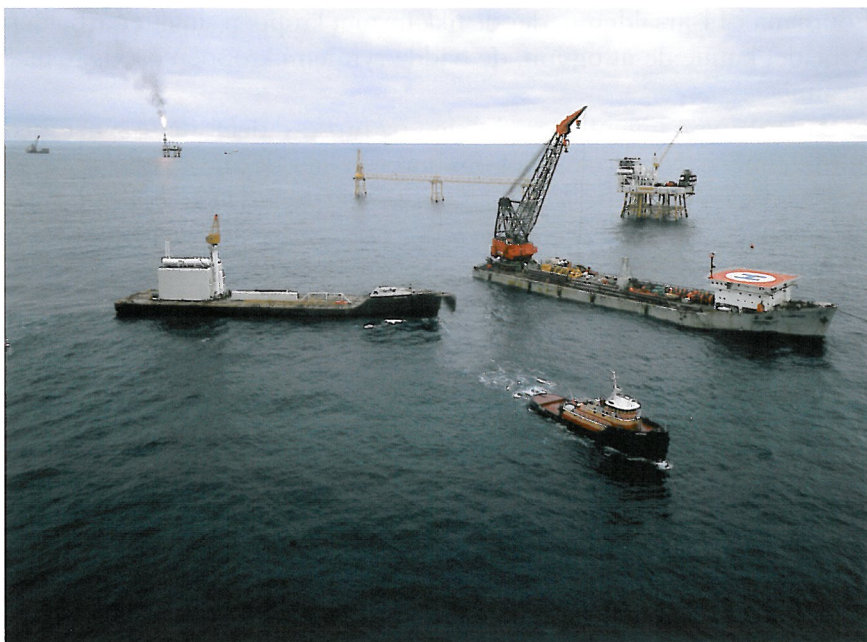
Oppbygging av Ekofisk senteret. Prøveproduksjons- plattformen Gullfide i bakgrunnen.
