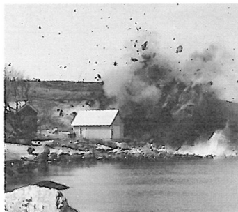
Den første sprengningen til det som skulle bli Dusevikbasen.
