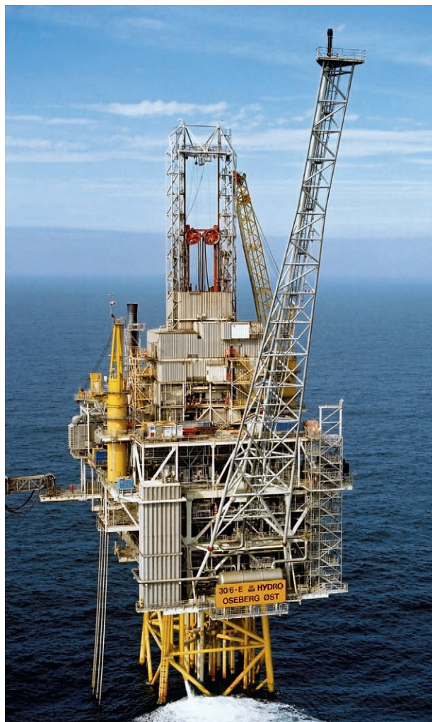
Oseberg Øst. Foto: Terje S. Knudsen/Statoil
