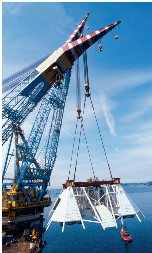
TOGI-modulen løftes. Foto: Norsk Hydro
