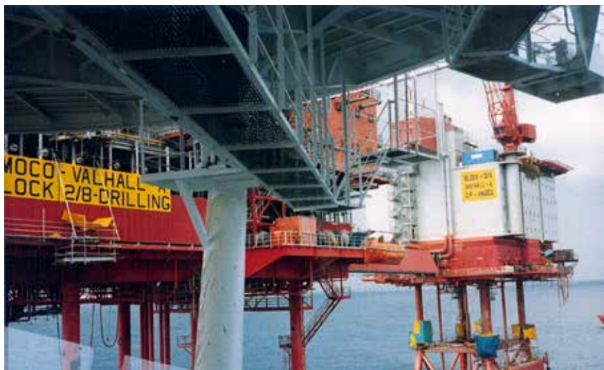
Boligplattformen QP og boreplattformen DP sett fra prosess- og produksjonsplattformen PCP. Foto: BP
