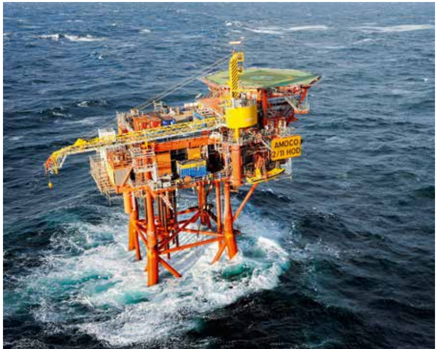
Hod er en enkel, vanligvis ubemannet brønnhodeplattform. Den fjernstyres fra Valhall 13 km unna, og var Nordsjøens første ubemannede plattform da produksjonen startet i august 1990. Foto: BP
