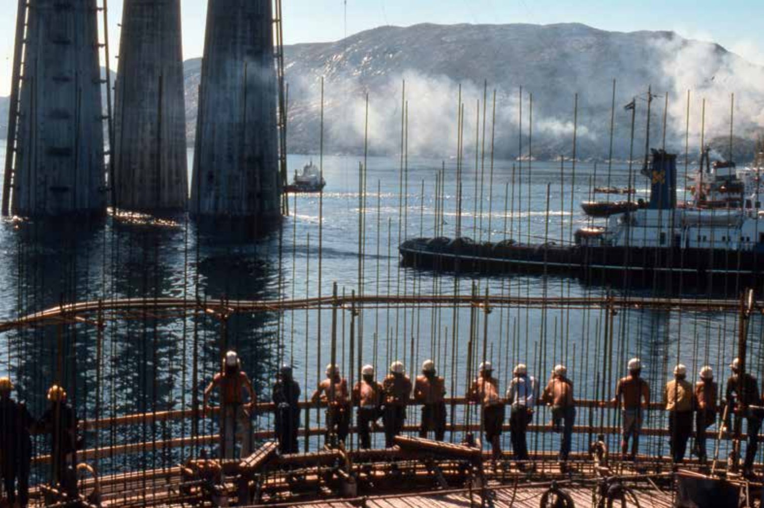
En fin dag på jobb hos Norwegian Contractors i Jåttåvågen. Det var mye hardt arbeid med jernbinding og støyping i betong. Foto: Kåre Moen/NOM
