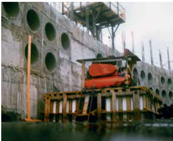
Dykking på innsiden av bølgebryterveggen på Ekofisk-tanken for å løsne oppdriftsdekslene for oppheising. Dykkingen foregikk fra en åpen flåte utstyrt med luftkompressor. Foto: Leif-Tore Skjerven/NOM
