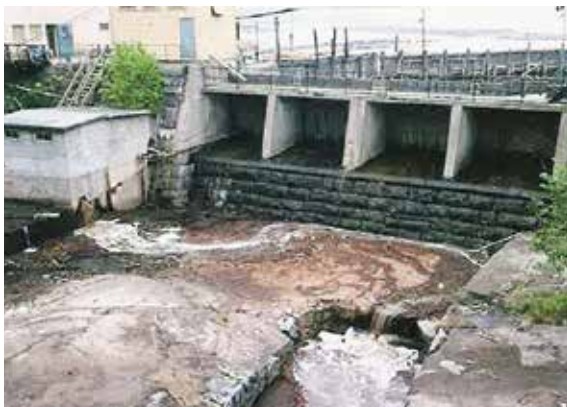
Farrisdammen i dag. Den opprinnelige betongdemningen kan ses til venstre for fossen. Foto: Byggeindustrien
